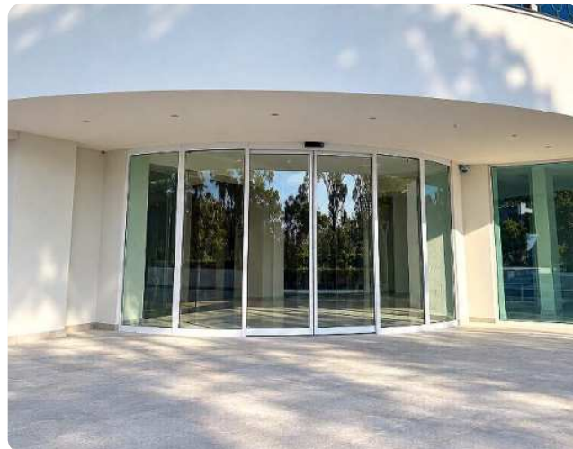
Raio à medida, a seguir a fachada do edifício
